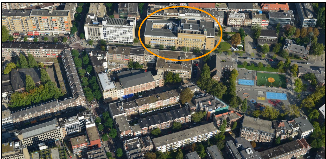
Afbeelding 4: Zicht op het gebouw van het Oogziekenhuis waar dit bestemmingsplan zich op richt.
