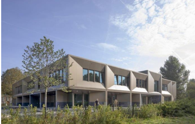
HPC Zuidwijk (nieuwbouw)
