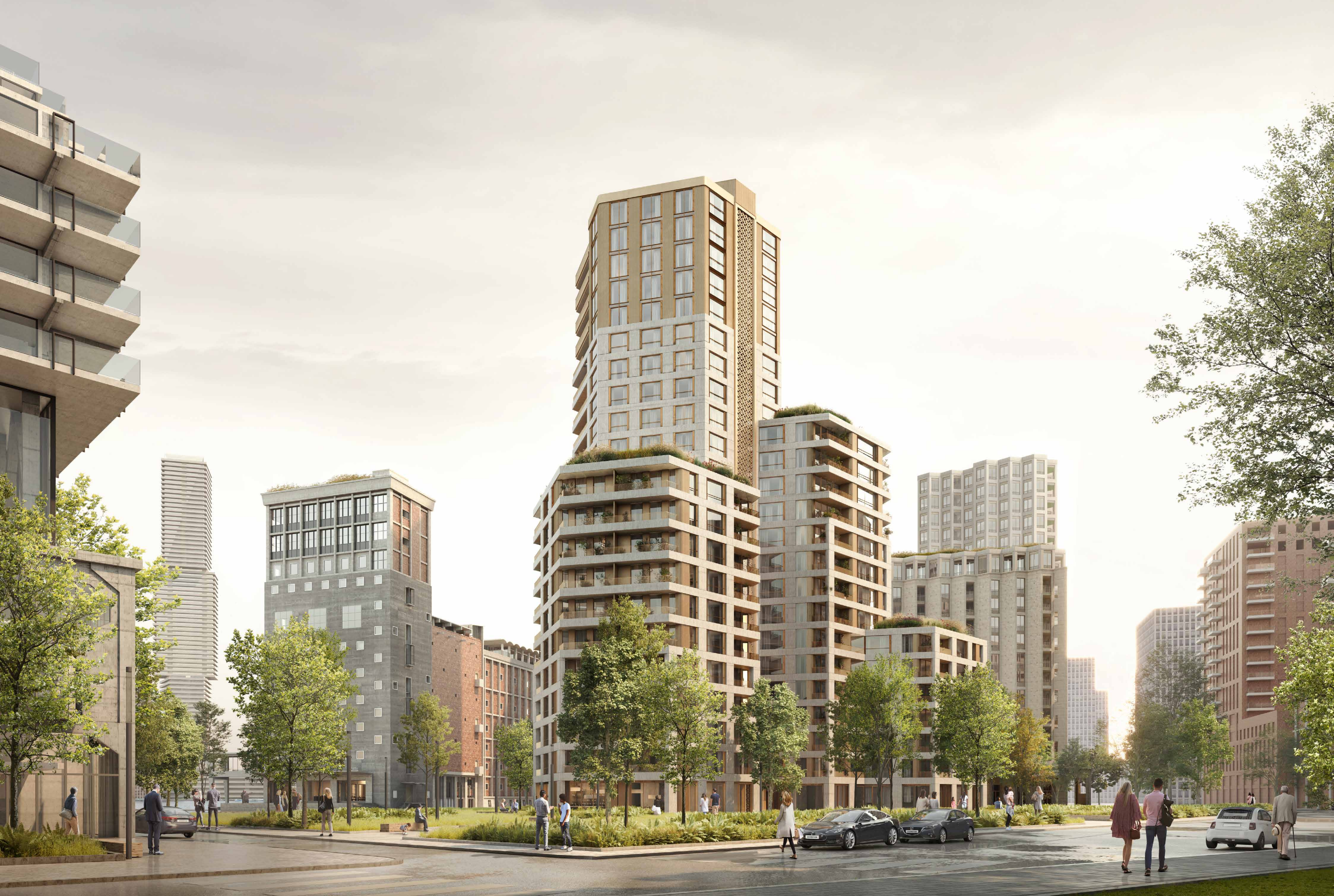
VELDBLOK GEZIEN VANAF DELIPLAAN
